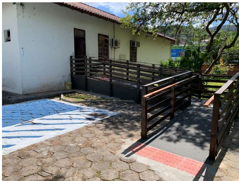
Imagem 04: Rampa de acesso edificação 02.
