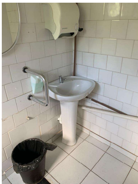
Imagem 09: Banheiro PCD Prédio 01.
