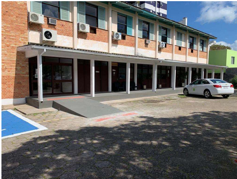
Imagem 03: Acesso ao prédio 01.
