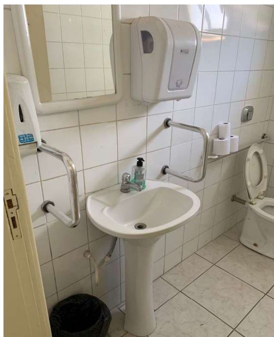
Imagem 10: Banheiro PCD Edificação 02.
