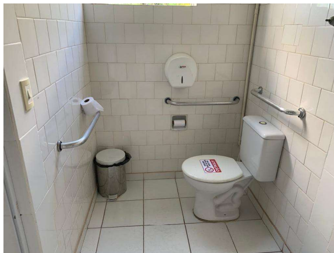
Imagem 08: Banheiro PCD Prédio 01.
