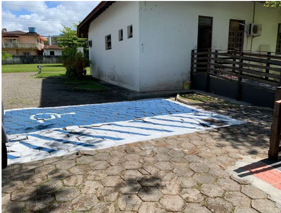
Imagem 06: Vaga PCD edifício 02.
